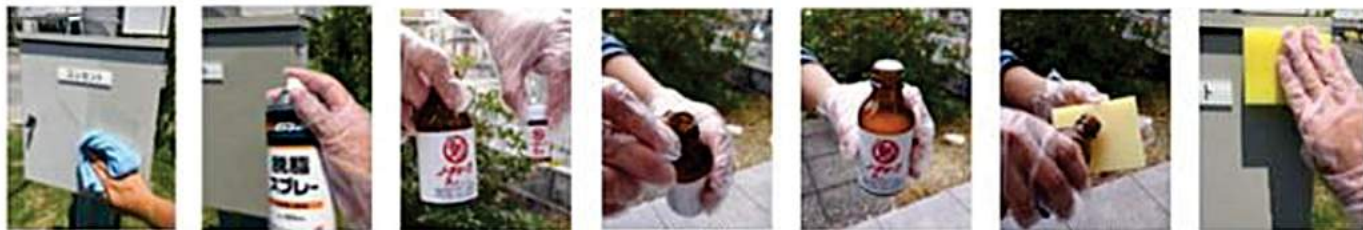
水拭き 脱脂 ノーチョーク A液B液 A液B液混合 中栓をする スポンジに均等に付ける 均一に塗布
